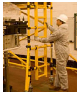
Estabilizadores conferem acréscimo de segurança
