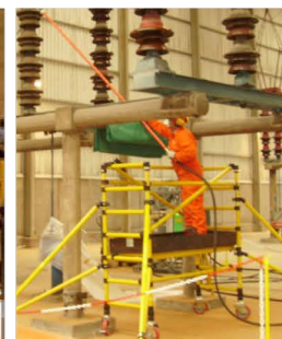
Material não condutor protege os operadores contra correntes elétricas até 220 kV
